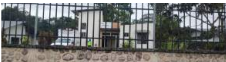
Fotografía 13: Puesto de salud Shawi
