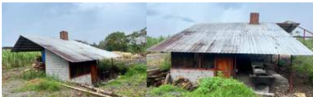
Fotografía 31: Panelera Shawi Fuente y elaboración: Equipo Consultor
