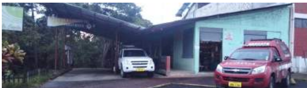
Fotografía 17: Estación de Bomberos
