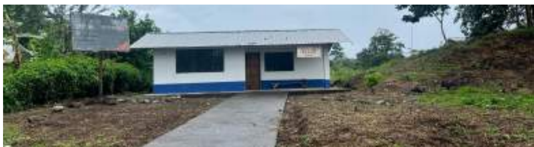
Fotografía 12: Puesto de salud Shawi
