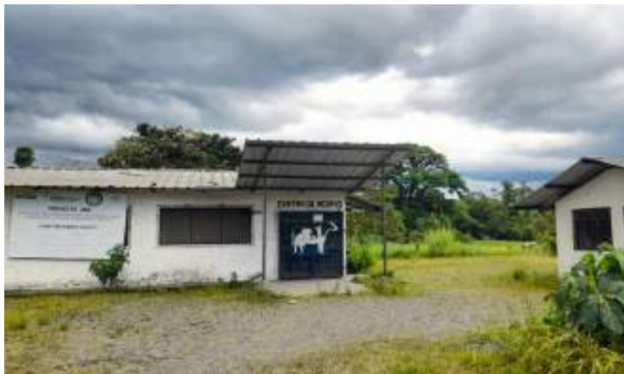
Fotografía 83: Centro de acopio
