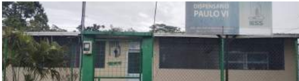
Fotografía 14 Puesto de salud Shawi
