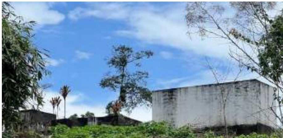
Fotografía 62: Cementerio_ El Rosario Fuente: Equipo Consultor
