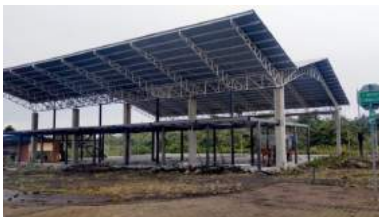
Fotografía 20: Mercado Municipal (en construcción)
